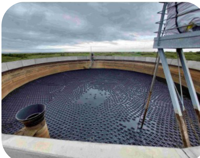
Overdækning på Skagen Renseanlæg
