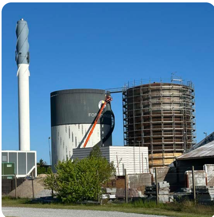
Opførelse af elkedel og akkumuleringstank
