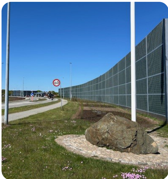
Støjvæg på Vendsysselvej
